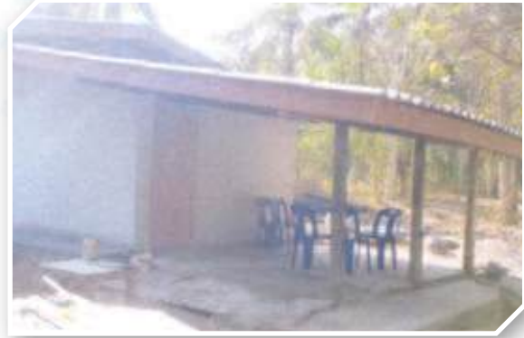
หลังการซ่อมแซม/ปรับปรุง
