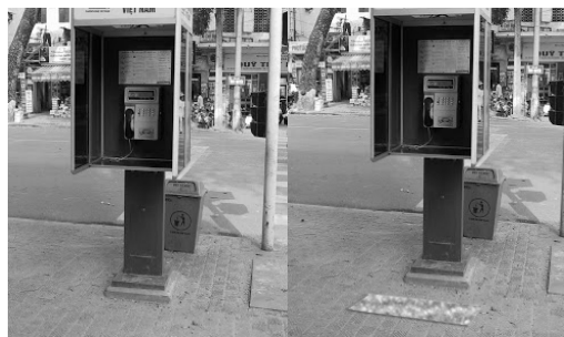
รูปที่ ๑๗ แสดงภาพก่อนและหลังการติดตั้งพื้นผิวต่างสัมผัสบริเวณที่เป็นอุปสรรค
