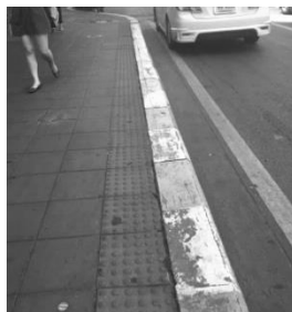
รูปที่ ๑๔ ตัวอย่างพื้นผิวต่างสัมผัสชนิดเตือนบนทางเท้า ถนนรัชดาภิเษก
