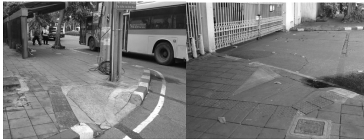
รูปที่ ๑๑ ตัวอย่างพื้นผิวต่างสัมผัสบนทางเท้า ถนนอังรีดูนังต์
