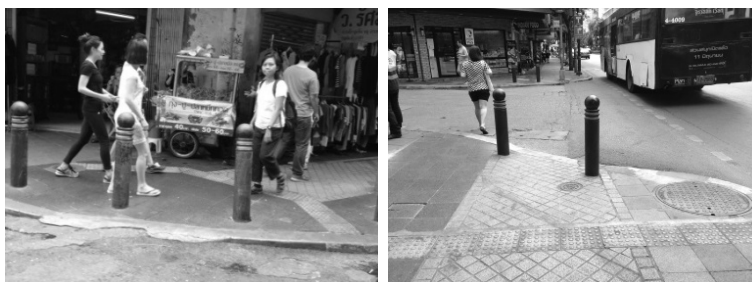
รูปที่ ๑๕ ตัวอย่างพื้นผิวต่างสัมผัสบนทางเท้า ถนนสีลม
