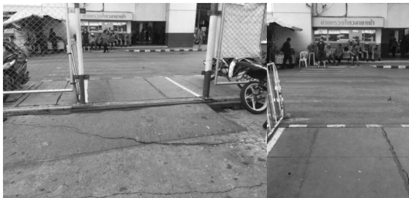
ภาพที่ ๑๒ จุดตัดข้ามถนนก่อนเข้าถึงอาคารหลัก
