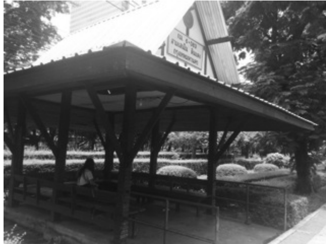
ภาพที่ ๖ ป้ายหลังคาจั่วติดบันลมนไม้ฉลุ
