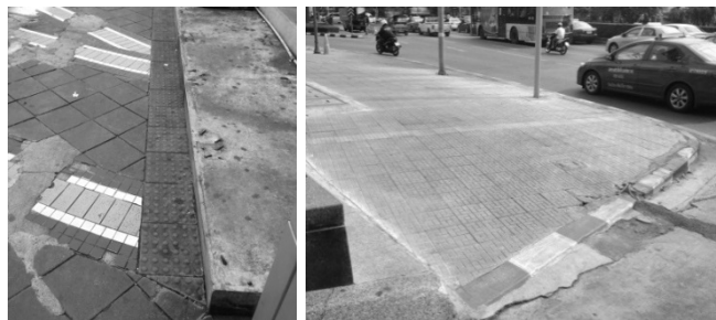
รูปที่ ๙ ตัวอย่างพื้นผิวต่างสัมผัสบนทางเท้า ถนนพญาไท
